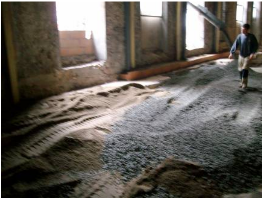
Foto 8: Distribució de la grava per damunt de la sorra.
