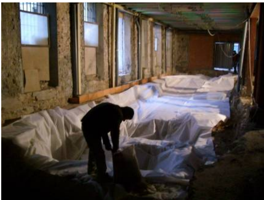
Foto 4: Vista de la col.locació del Geotèxtil des del extrem est.
