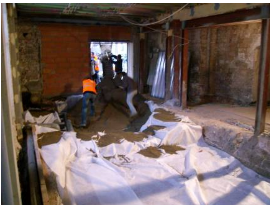
Foto 5: Distribució de la sorra per sobre del Geotèxtil.
