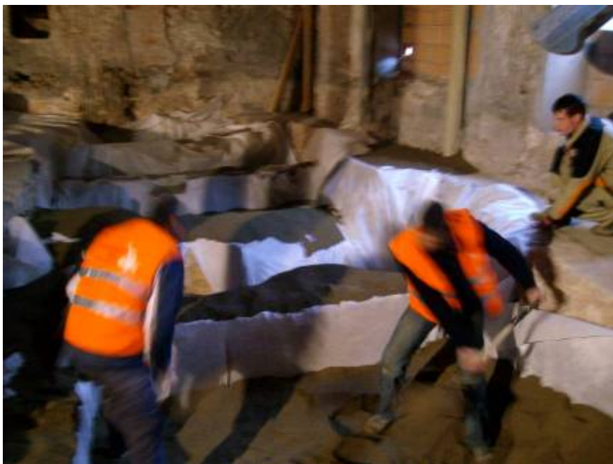
Foto 6: Distribució de la sorra per sobre de les estructures.
