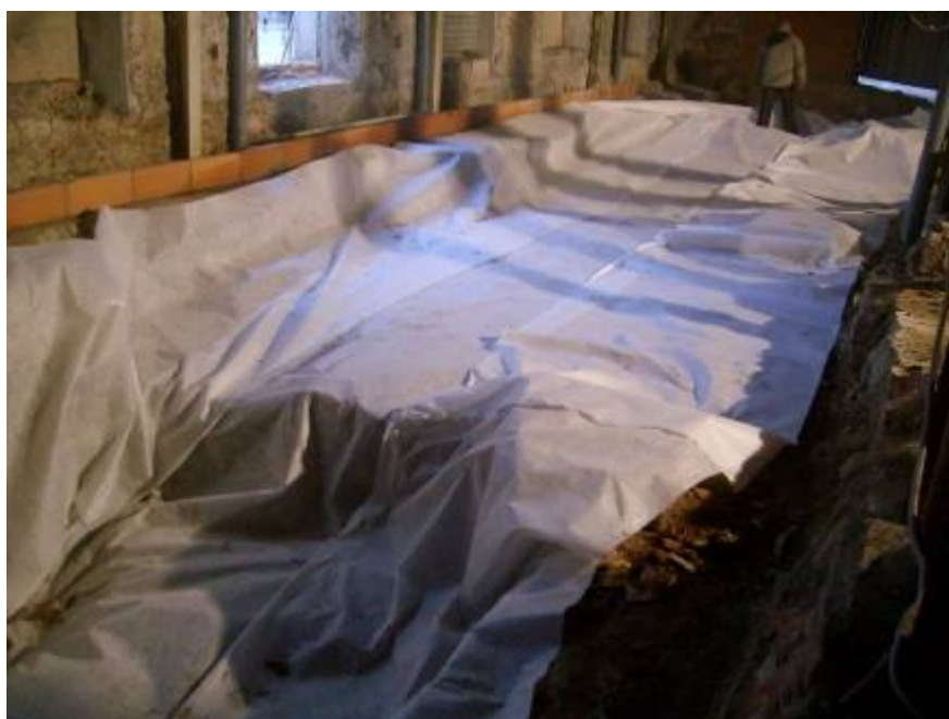
Foto 3: Col.locació del Geotèxtil.
